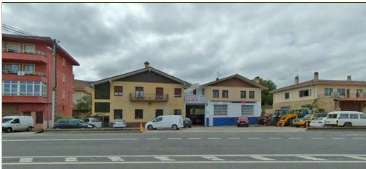
Edificaciones residenciales sin condiciones adecuadas de urbanización
