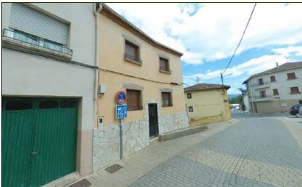
Casa nº 59 de calle Arrabal
