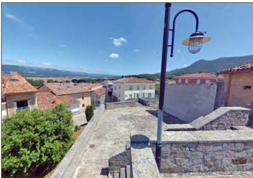
Urbanización de escaleras y plataformas
