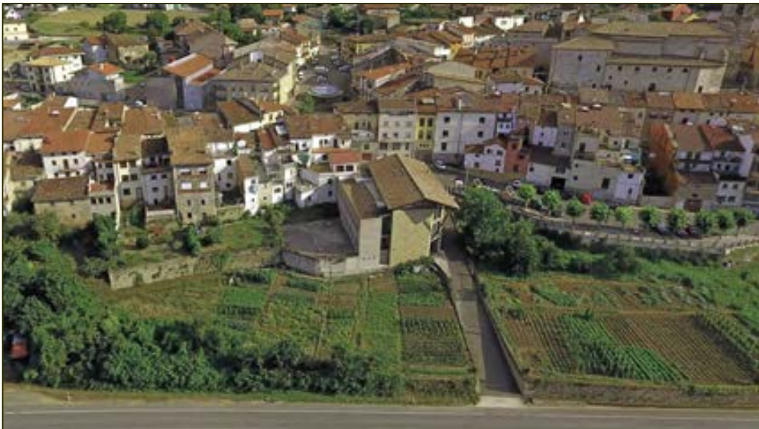
La casa de cultura como una barrera que parte la fachada urbana en zona este y oeste
