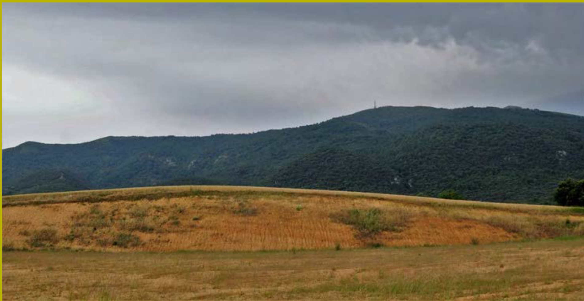
Vista actual de los procesos erosivos sobre los taludes de desmonte
