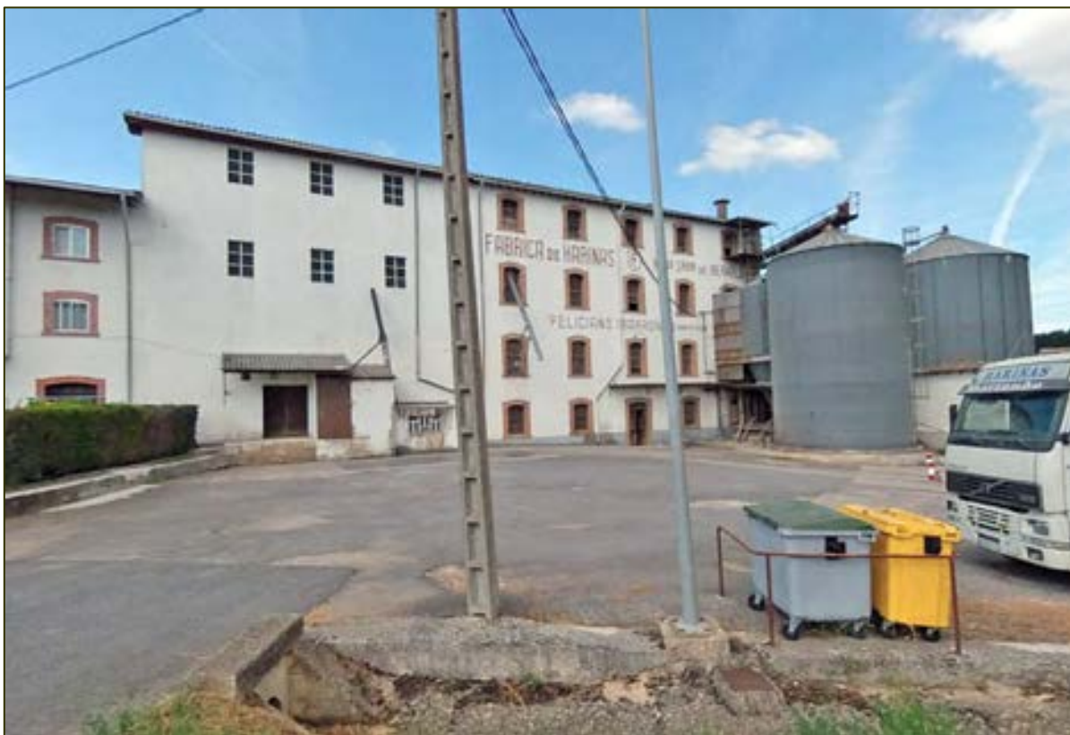
Urbanización inadecuada del frente de la fábrica de harinas
