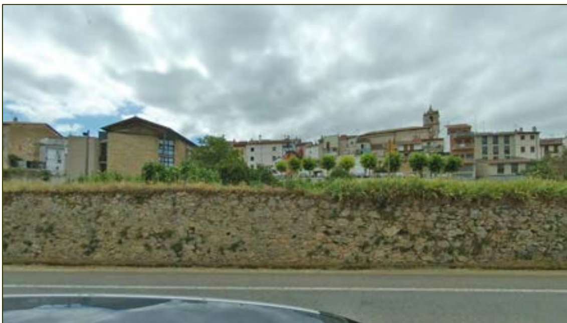
Muro de contención como obstáculo físico y visual para la percepción de la fachada urbana
