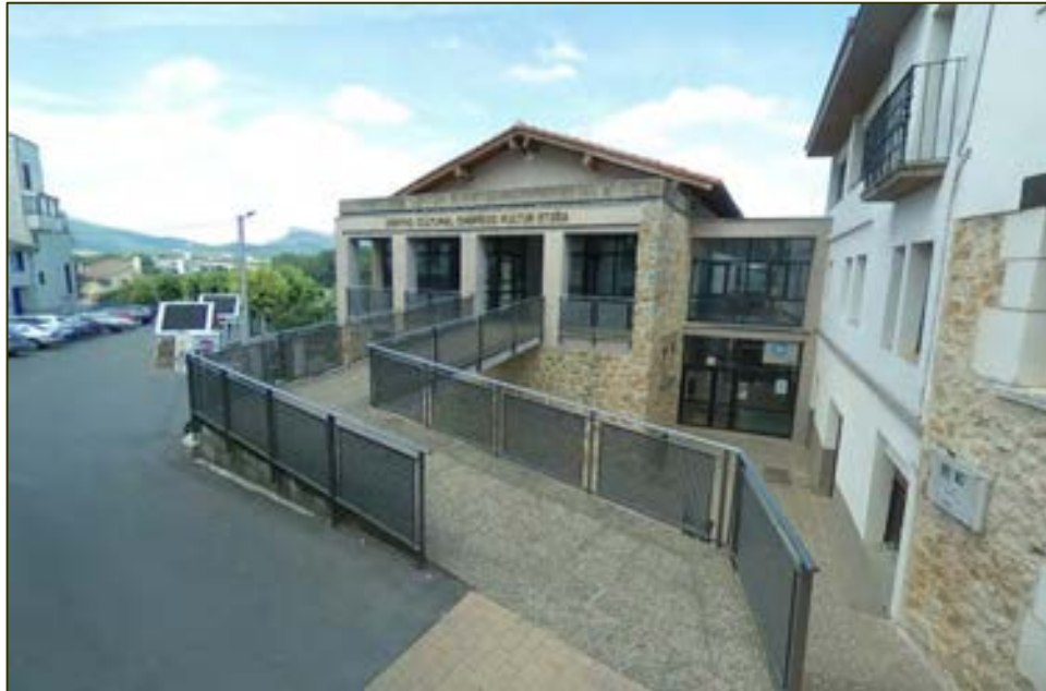
Accesos a dos niveles mediante escaleras y pasarela
