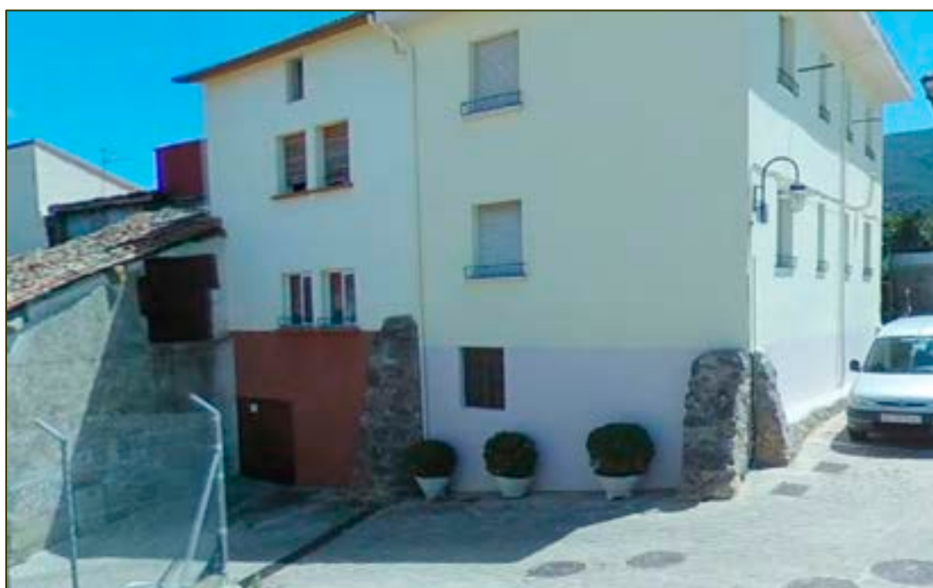
Contrafuertes o muros adosados a la antigua muralla en la calle Subida al Castillo
