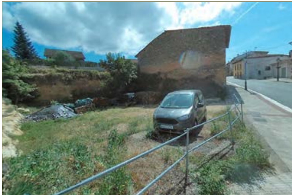
Solar excavado con taludes casi verticales y acopio de madera
