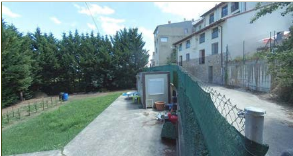
Tramo inicial por Debajo de la Casas. Parcela privada con cierres inadecuados
