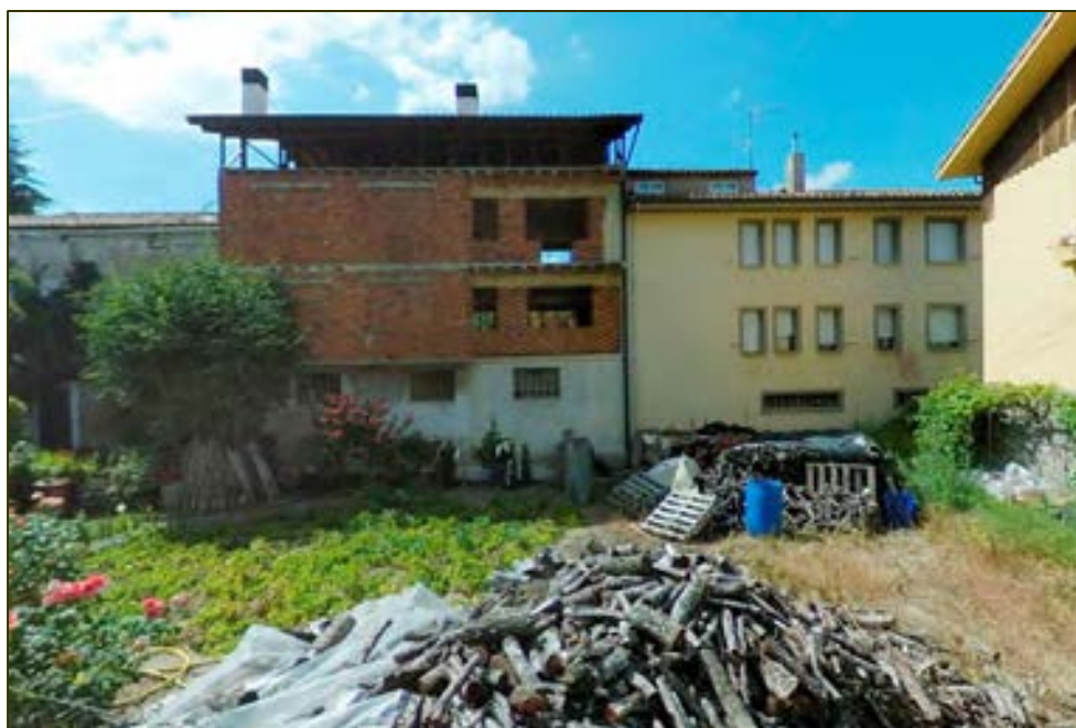
Obra de construcción en apariencia paralizada y acopio de chatarra, en calle Arrabal
