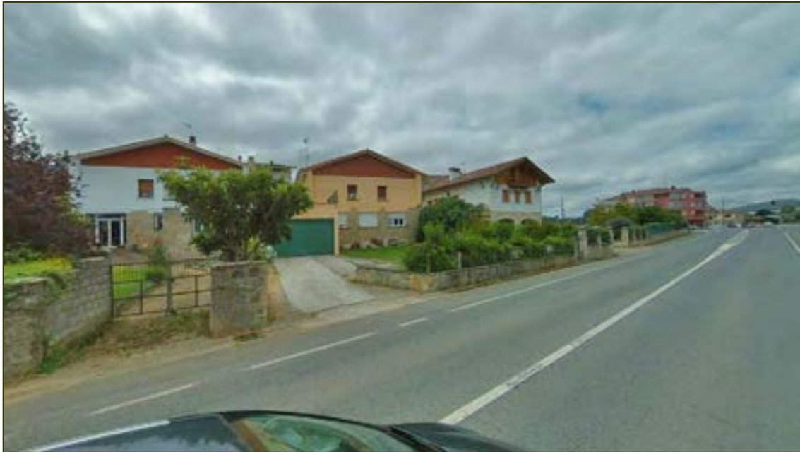
Accesos a parcelas privadas directamente desde la carretera A-132
