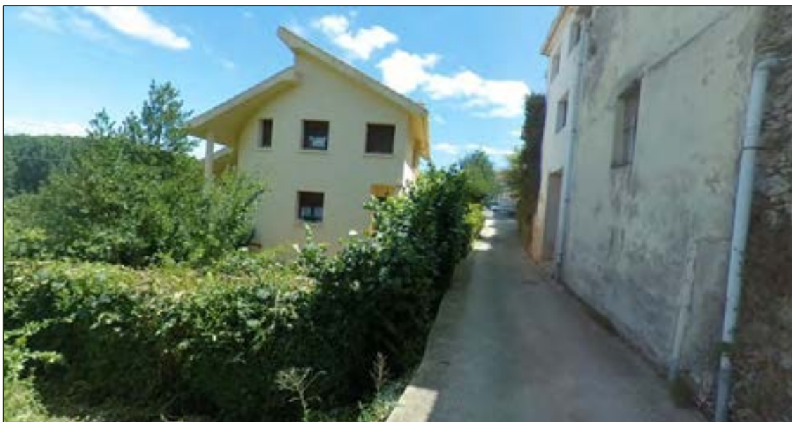
En el centro edificación saliente del plano de fachada urbana, disconforme con el planeamiento
