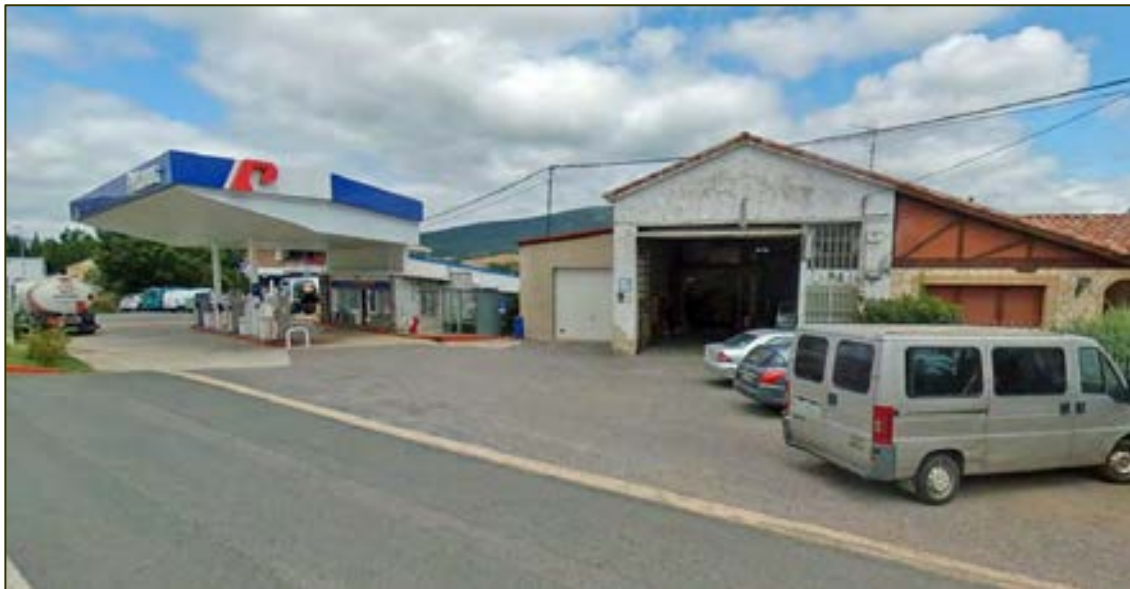
Pabellón industrial adosado a edificación residencial
