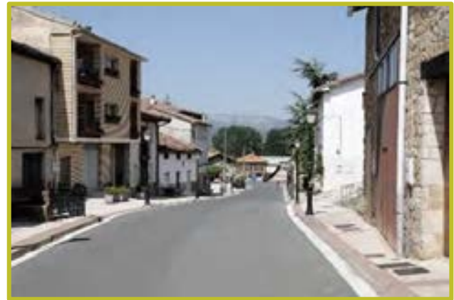
Figura 27. Edificación de vivienda compacta.
