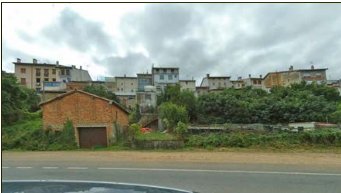
Construcción al borde de la carretera y chabolas asociadas a las huertas
