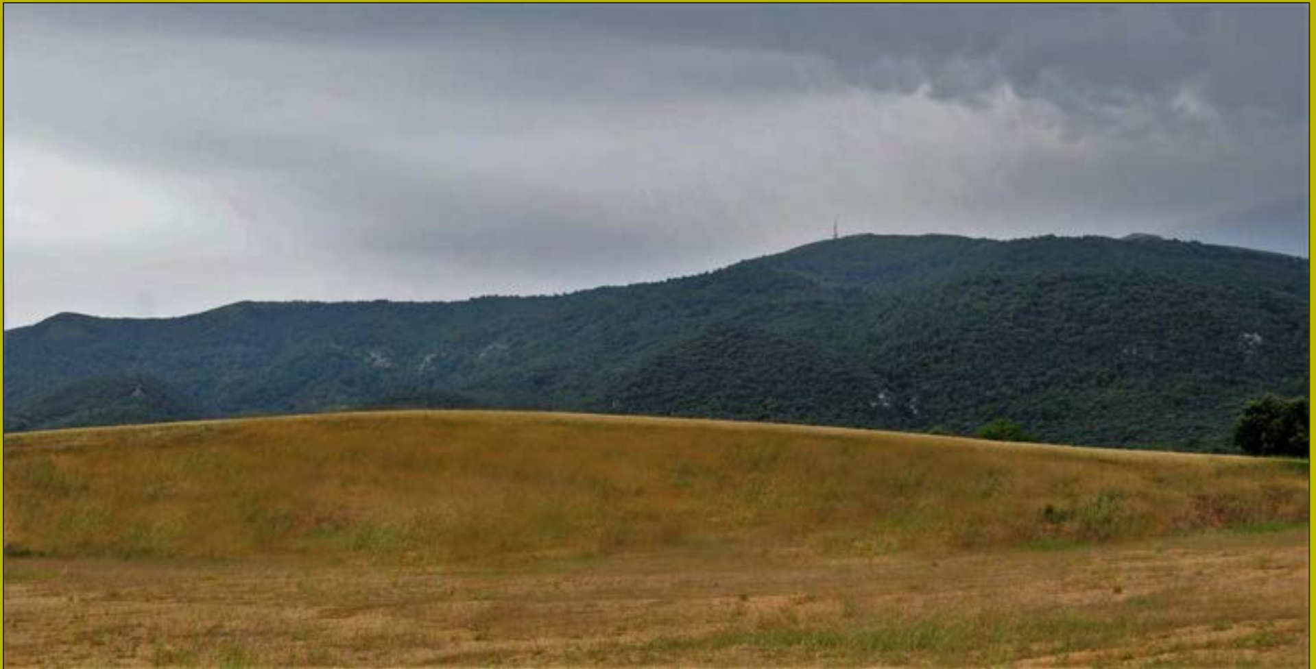
Fotomontaje con taludes revegetados con hidrosiembra
