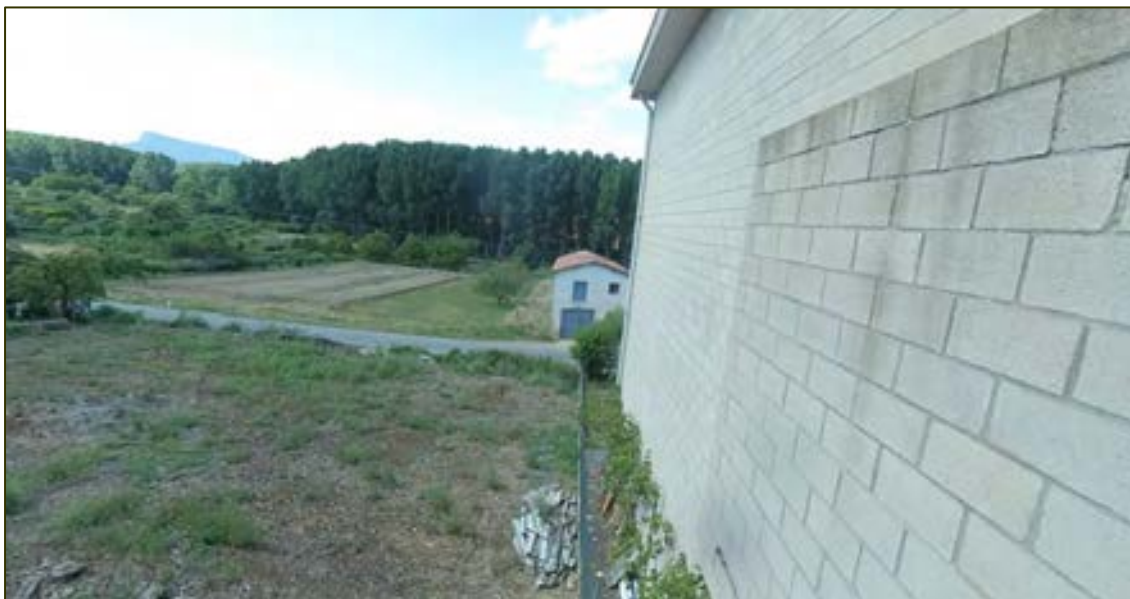
Muro de bloque de hormigón y terreno sin acondicionar
