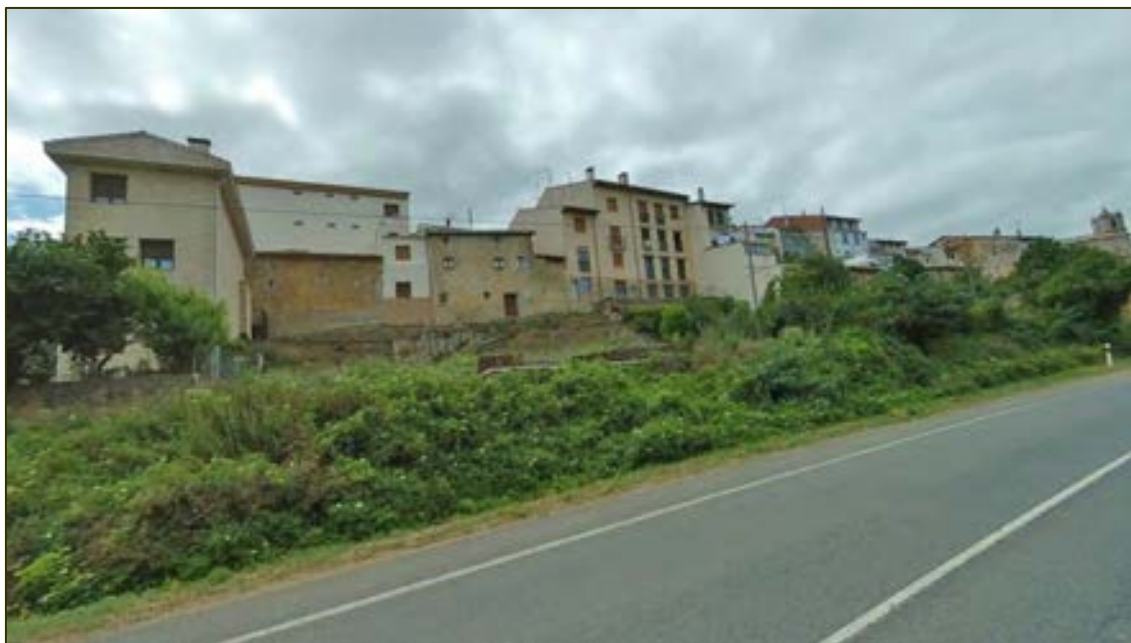
Fachadas traseras descuidadas, taludes y terrenos en estado semi salvaje
