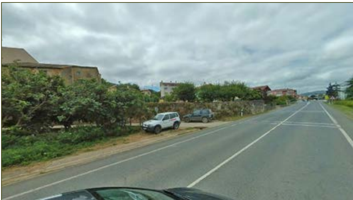
Inicio de la calle Debajo de las Casas y muros de cierre de parcelas de excesiva altura
